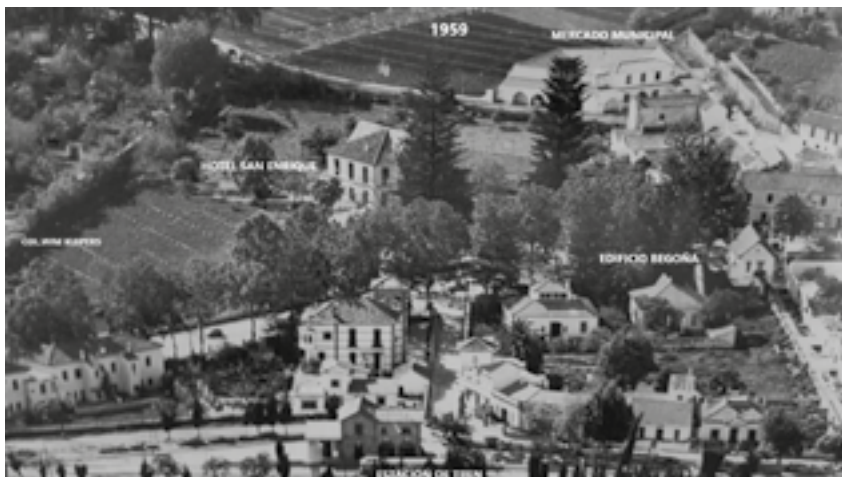
Vista aérea de Torremolinos, año 1959. Identificación del lugar donde actualmente se encuentra el Edificio Begoña. Colección de Wim Kuipers.
